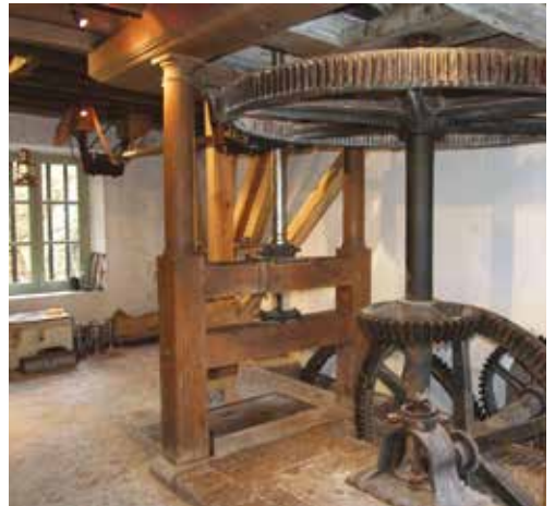
Roue à augets, engrenages, mécanisme hydraulique, meules en pierre ont été rénovés.
